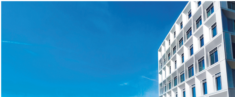
Der Neubau des Kantonsspitals in Frauenfeld.
