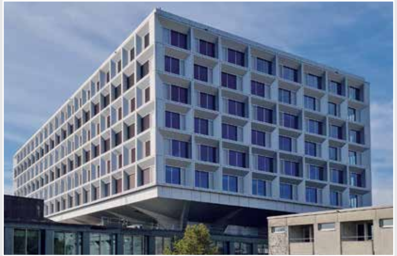
«Horizont». Nach einer Bauzeit von nur vier Jahren wurde 2020 der Neubau in Betrieb genommen.
